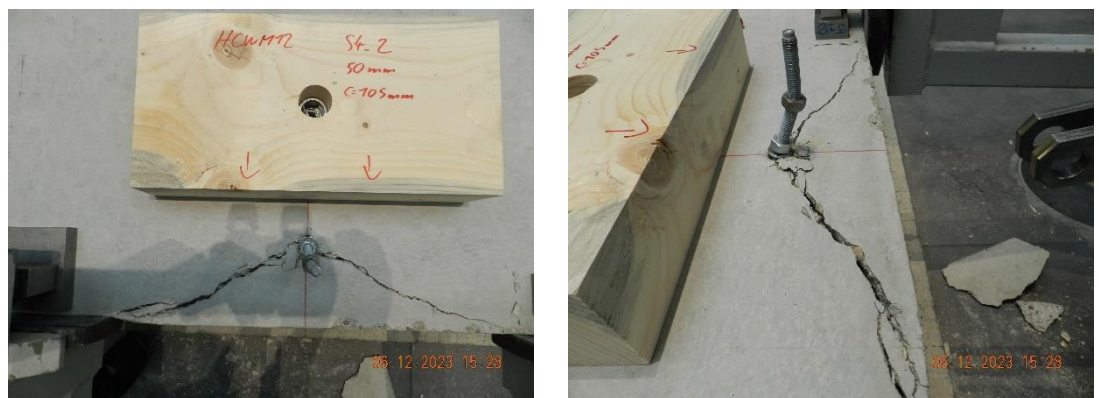
Abb. 4.2: Betonkantenbruch, Beispiel c_1 = 105 mm, t_m = 50 mm
