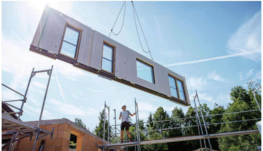
Abb. 2.5: Montage einer vorgefertigten Holztafel auf der Baustelle
