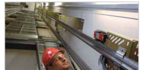
Bedoeld en toegelaten voor Vermoeidheidsbelastingen, bijv. montage van liften.
