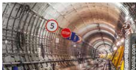
Fissaggio di cartelli o tubi di alimentazione nei tunnel.
