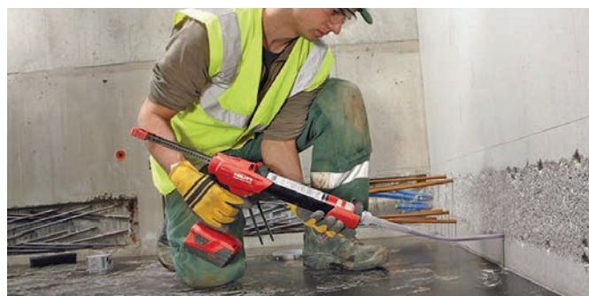
Bild 1 Anwendungsbeispiel eines nachträglichen Bewehrungsanschlusses Example of a post-installed rebar application
