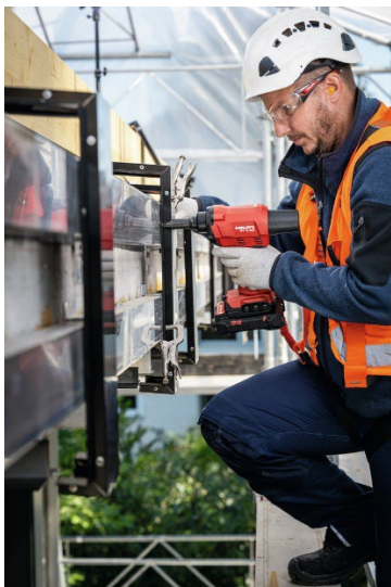
Bild 4: Das einhändige Arbeiten sorgt vor allem in der Höhe für mehr Sicherheit.
