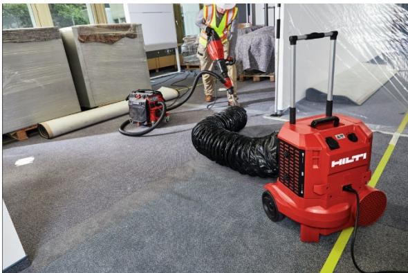
Bild 5: Reduzierung des Staubes am Entstehungsort mittels Staubschlauch am Lufteinlass des Air Cleaners.
