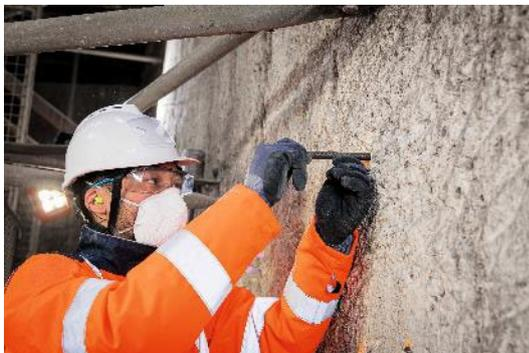
Bild 3: Einschieben des Bewehrungsstabs in das verfüllte Loch
