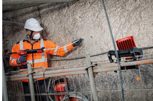
Bild 2: Präzises Dosieren des Injektionsmörtels mit Hilti Auspressgerät
