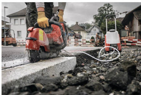
Bild 4: Der Akku-Trennschleifer DSH 700-22 hat die gleiche Schnittleistung wie ein Benzin-Trennschleifer in Kombination mit Wasserzuführung und optimierten Trennscheiben.
