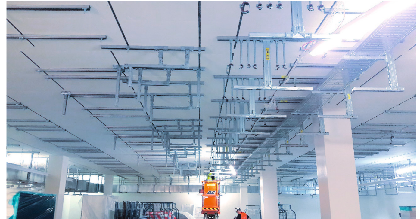
Abbildung 8: Montage der Befestigungstechnik auf der Baustelle
